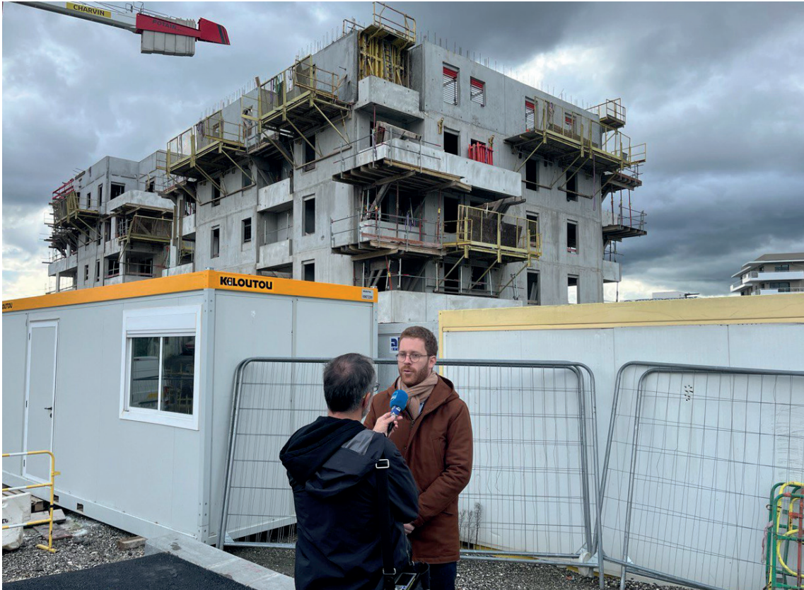
Visite du chantier de la Zac de Pré Billy, Haute Savoie
